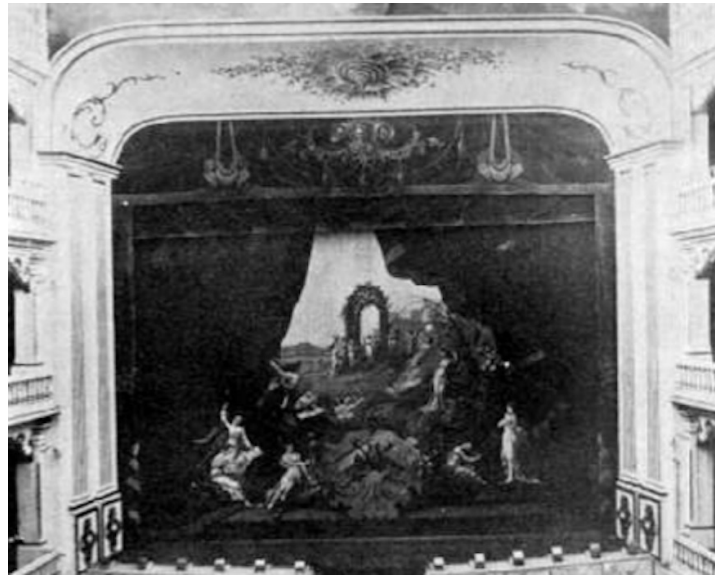
Figura 4. “...Telón de boca de palco escénico”
